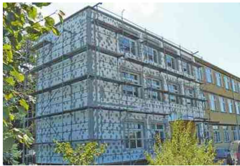
Postępujące prace przy budynku Szkoły Podstawowej w Skrwilnie
