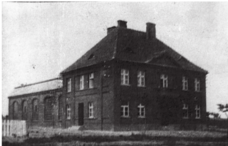
Elektrownia Miejska w Rypinie przy ulicy Jasnej 6 (fot. 1928)
