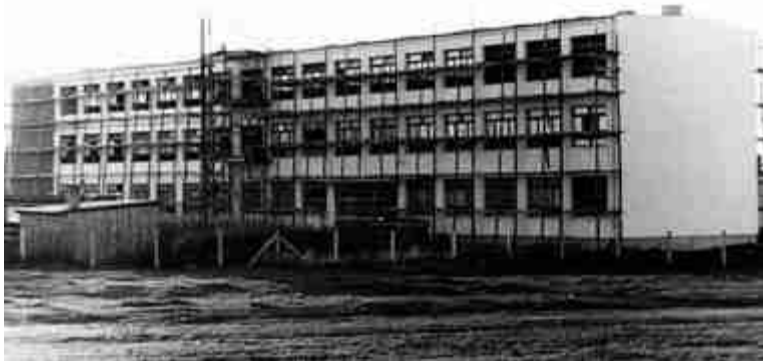
Budowa gmachu Technikum Ekonomicznego przez PBRol (fot. 1970)
