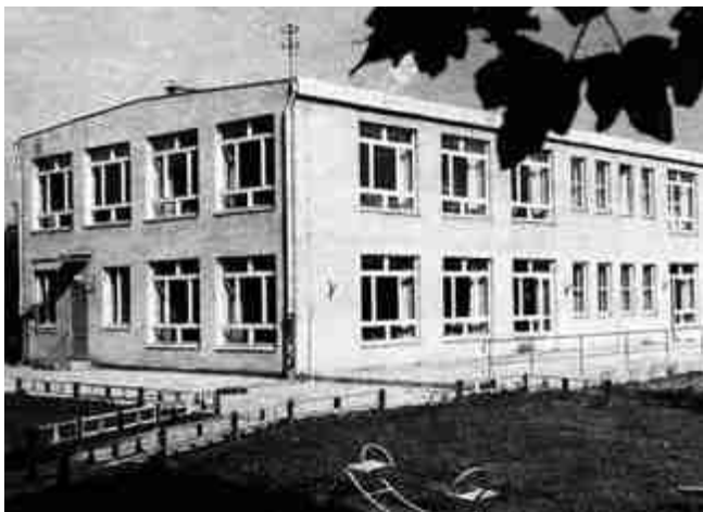
Przedszkole przy ulicy Młyńskiej w Rypinie zbudowane przez PBRol (fot. 1971)
