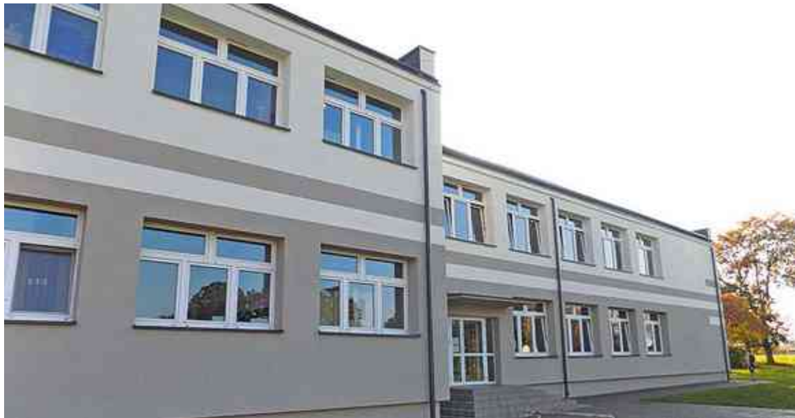
Tak prezentuje się budynek szkoły po remoncie
