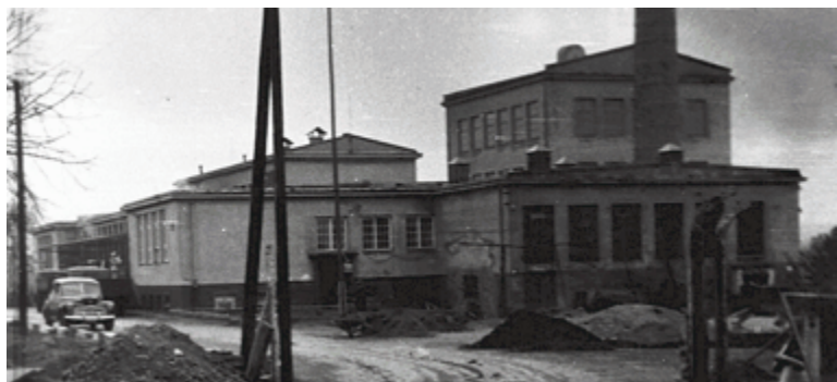
Zakłady Mleczarskie w Rypinie w trakcie rozbudowy i budowy proszkowni (fot. 1951)
