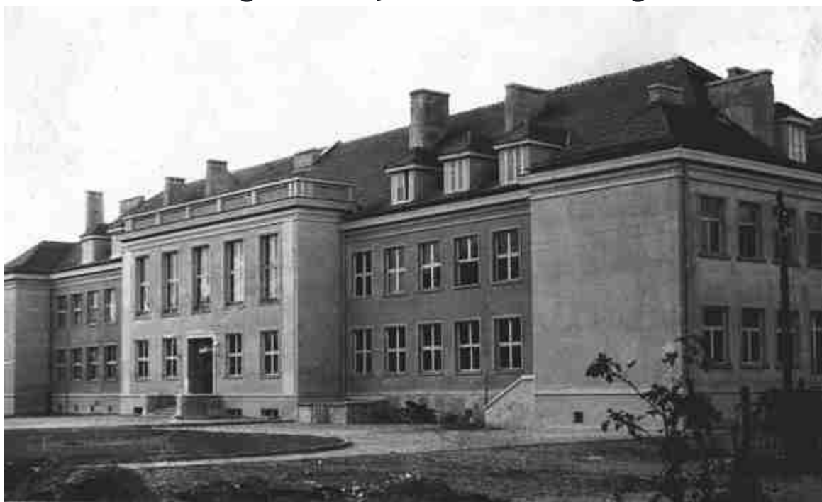
Szkoła Podstawowa nr 2 w Rypinie wybudowana przez Rypińskie Przedsiębiorstwo Budownictwa Rolniczego w 1960 roku (fot. 1960)
