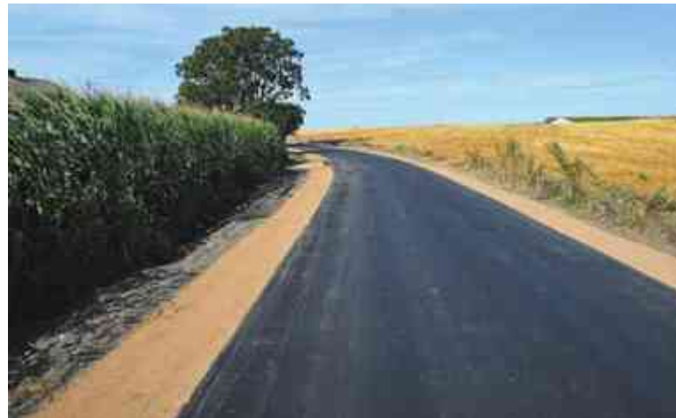
Gotowy odcinek Ostrowite - Łączonek
