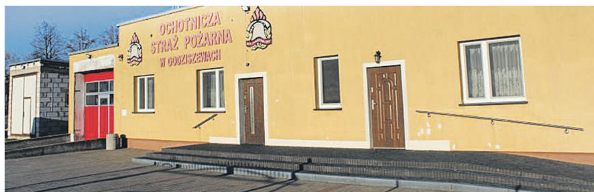
Rozbudowa strażnicy OSP w Godziszewach
