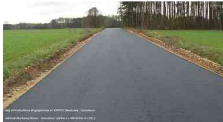
Etap II Przebudowa drogi gminnej nr 120425C Skudzaawy – Urszulewo odcinek Skudzaawy Nowe – Urszulewo (od km 2+300 do km 4+335)
