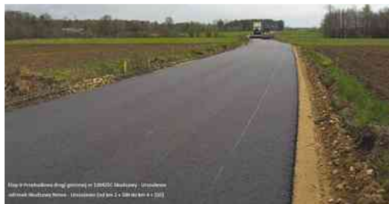
Etap I Przebudowa drogi gminnej nr 120425C Skudzaawy – Urszulewo odcinek Nowe Skudzaawy – Urszulewo (od km 2+300 do km 4+335)
