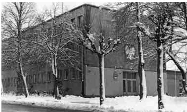
Budynek Sądu Powiatowego Rypinie (fot. ok. 1970)
