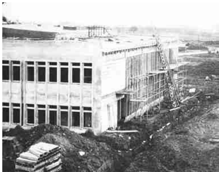
Fabryka Akcesoriów Meblowych w budowie (fot. 1974)
