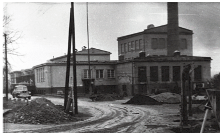
Zakłady Mleczarskie w Rypinie w trakcie rozbudowy i budowy proszkowni (fot. 1951)
