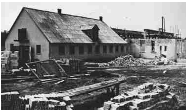
Teren przed budową zakładu RZPT w Cetkach (fot. 1966)
