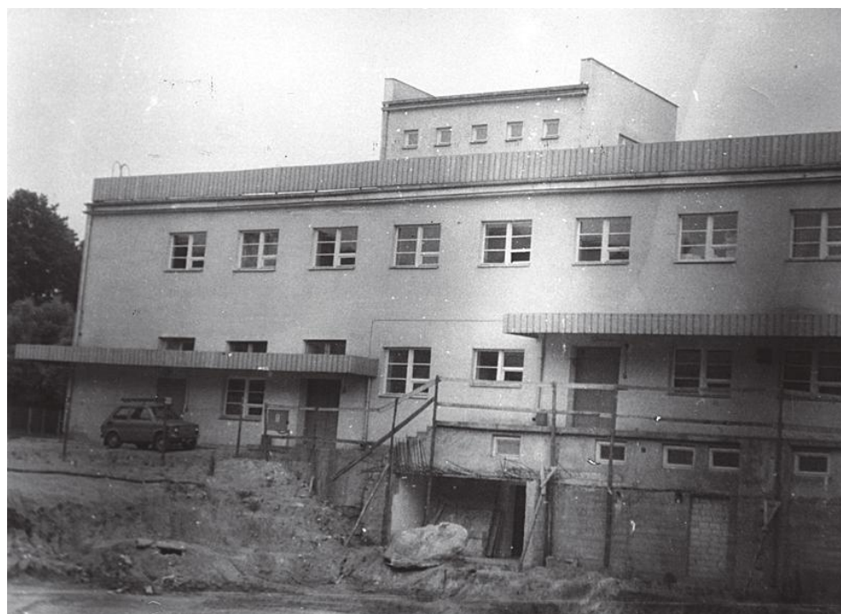
Budowa składu opału, w głębi budynek warsztatowo-magazynowy, obecnie Zakład Opieki Paliatywnej (fot. 1985)
