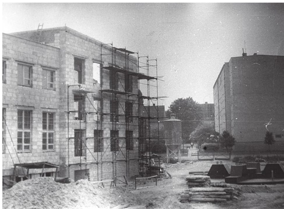
Budowa pralni i kotłowni (fot. 1985)
