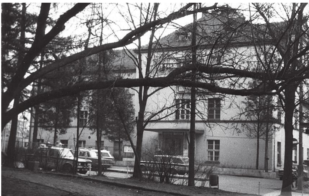
Budynek szpitala (fot. 1985)
